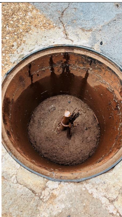
Foto 30 – SPDA (Caixa de inspeção de aterramento) no bloco principal
