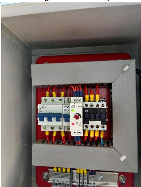
Foto 22 – Quadro de comando e força da casa de máquinas
