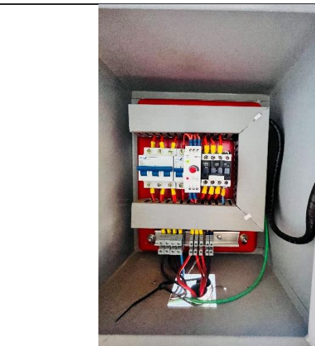
Foto 13 – Quadro de comando e força da Bomba de Incêndio
