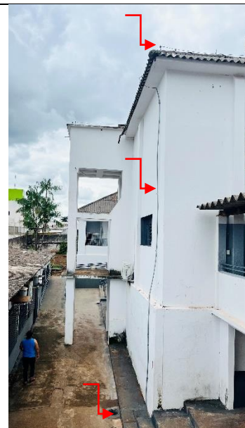
Foto 27 – SPDA (Captação, descidas e aterramento) no bloco principal
