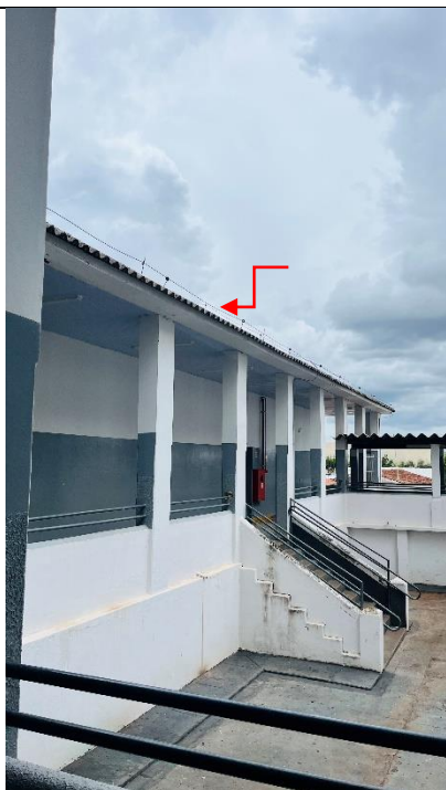
Foto 28 – SPDA (Captação) no bloco principal
